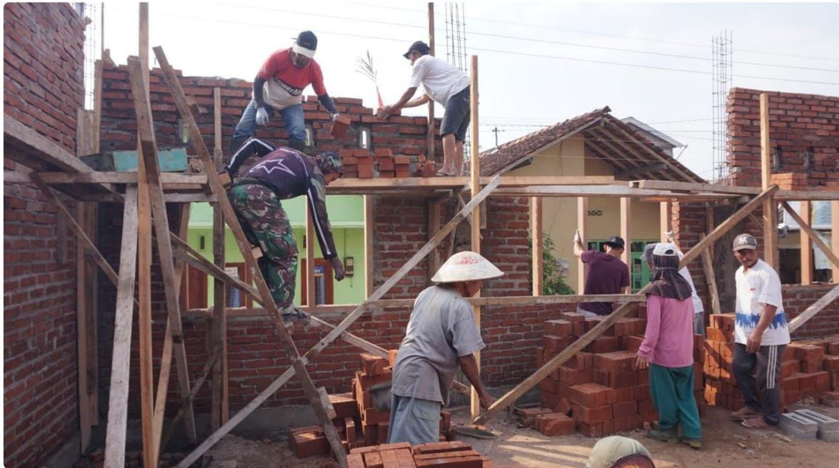
Lettu Inf Supriyanto selaku koordinator pembangunan TPQ menyampaikan bahwa saat ini pembangunan TPQ dalam tahap pemasangan batu bata untuk dinding dan akan dilanjut dengan pemasangan atap.
